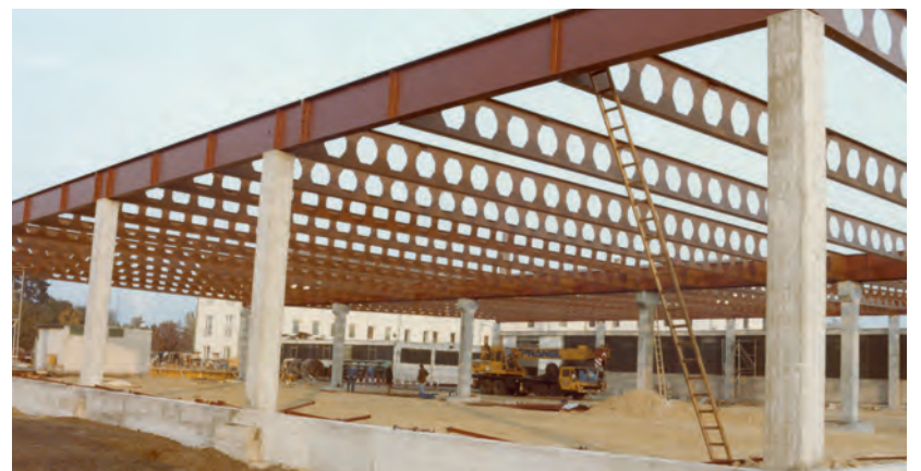
Mit einem Umbau 1972 und der Errichtung einer modernen Halle Ende der 1980er Jahre konnten die SKW sowohl die Produktion als auch den Versand deutlich ausbauen. Erstmals wurden am Standort auch Fernmeldekabel produziert.
