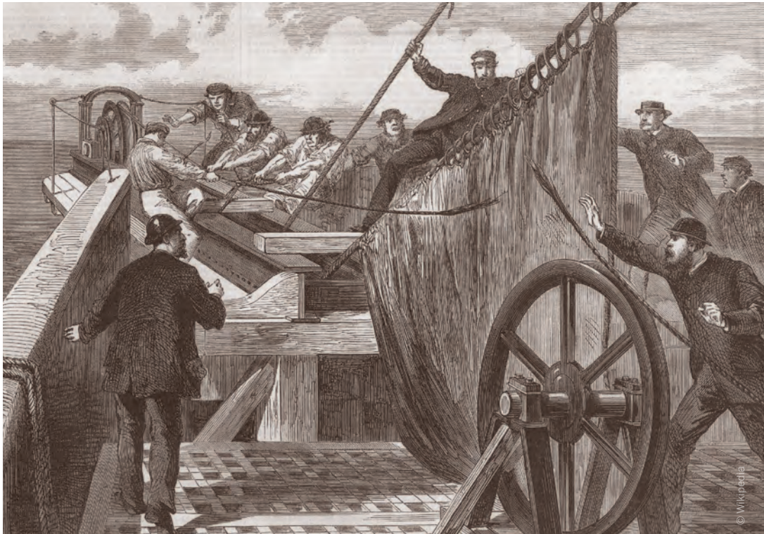
Bei der Verlegung des ersten Transatlantikkabels zwischen Europa und den USA kam es immer wieder zu dramatischen Unfällen.
