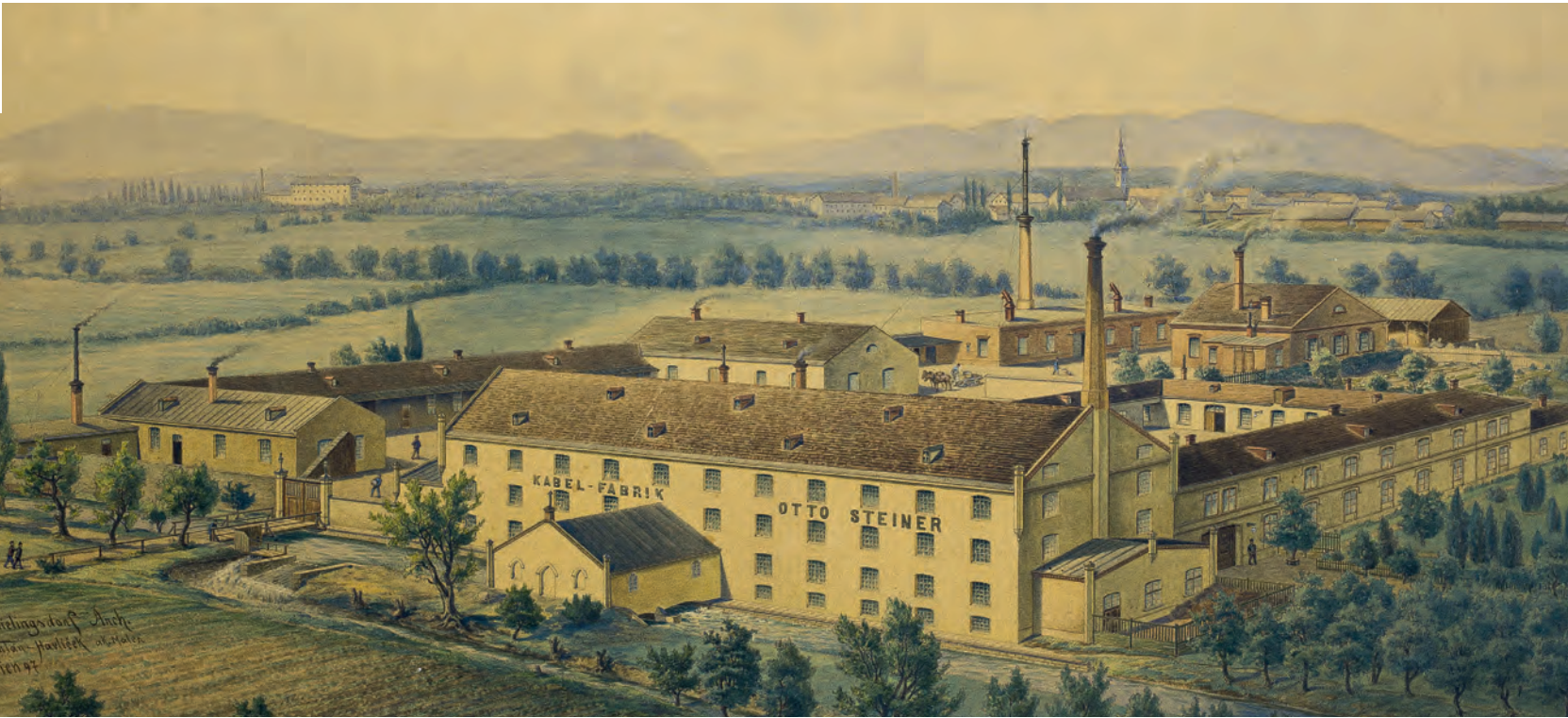
Auf dem Gelände am Fluss „Kalter Gang“ standen zuerst eine Mahlmühle und eine mechanische Spinnerei. Otto Steiner baute die kleine Fabrik ab 1891 zur Kabelfabrik Otto Steiner aus.
