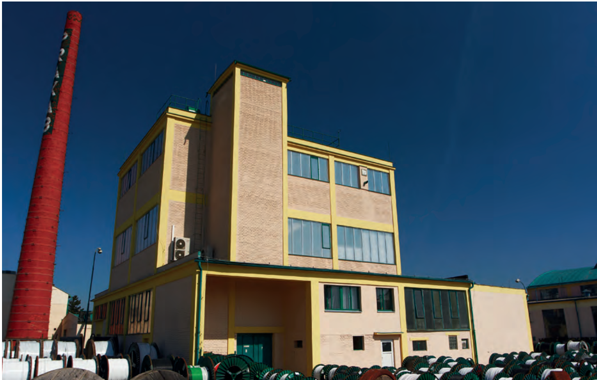
Aus einem sozialistisch geprägten Unternehmen wurde die PRAKAB in kürzester Zeit ein hochmoderner Industriebetrieb, der als das Vorzeigemodell innerhalb der SKB-GROUP gilt.
